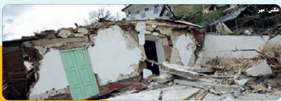
اثرات رانش زمین در روستای چه جا و تخریب خانه ها
