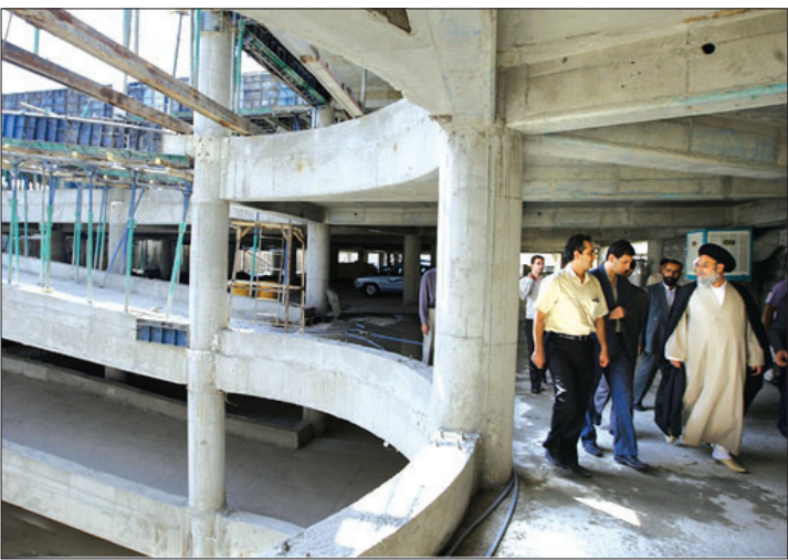
بازدید از پروژه‌های عمرانی شهرداری اصفهان
